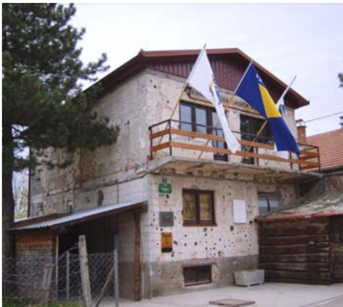
Il tunnel di Sarajevo
