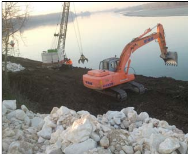
Ruspe al lavoro sul Po a Zaragnino
